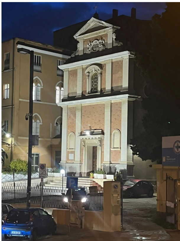
Cappella San Giuseppe — la facciata restaurata
